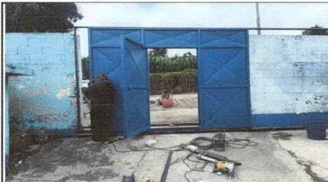
Foto 2: Porton del establecimiento en proceso de colocación.
