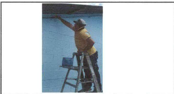
Foto 6: Muro interior en proceso de pintado
