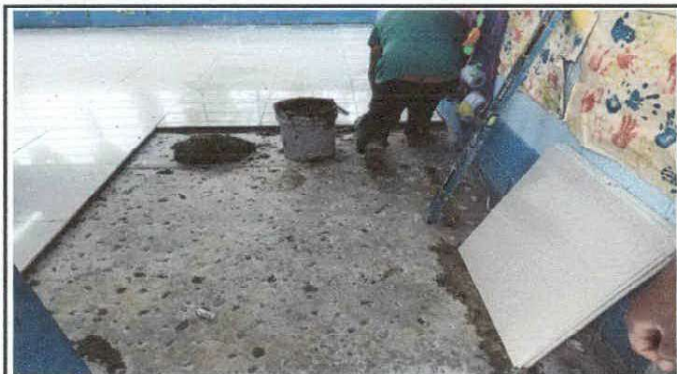
Foto 1: Piso de aulas en proceso de sustitución.
