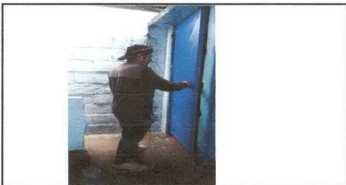
Foto 5: Puerta en proceso de sustitución
