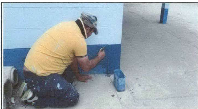
Foto 3: Muro exterior en proceso de pintado.
